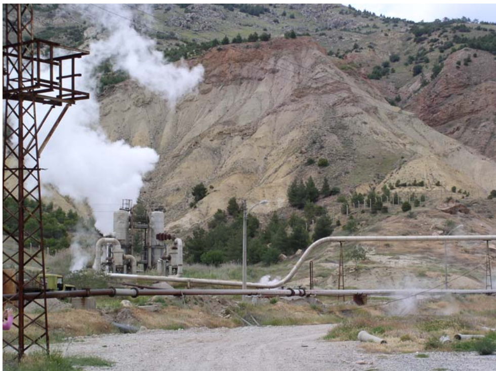
Фото 1. Геотермальное месторождение Кизидере (Турция): на переднем плане устье геотермальной скважины, оборудованное сепаратором, уступ на заднем плане – сброс (северное ограничение грабена Мендерс), контролирующей продуктивность геотермального резервуара.
