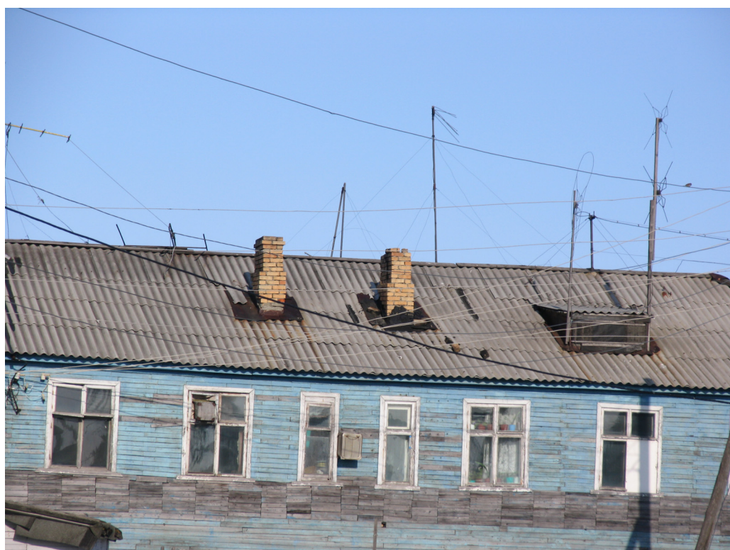
Рис. 1.8. Общий вид здания в пос. Корф.
