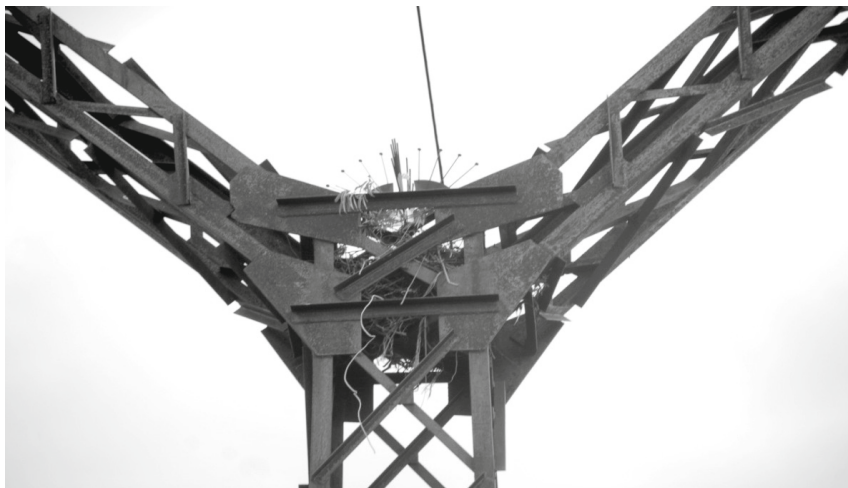
Рис. 3. Гнездо зимняка Buteo lagopus на опоре ЛЭП с антиприсадочным «птицезащитным» устройством веерного типа вблизи г. Елизово (июнь 2023 г., фото автора)
